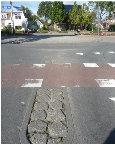
Rotonde is niet te zien, daarom rijden automobilisten er soms dwars overheen. Het voorstel vanuit Plaatselijk Belang is : er een fluorriserende verf om de rand van de rotonde aan te brengen, zodat die opvalt. De stenen in het midden van de weg heeft geen zin, niemand ziet ze.
