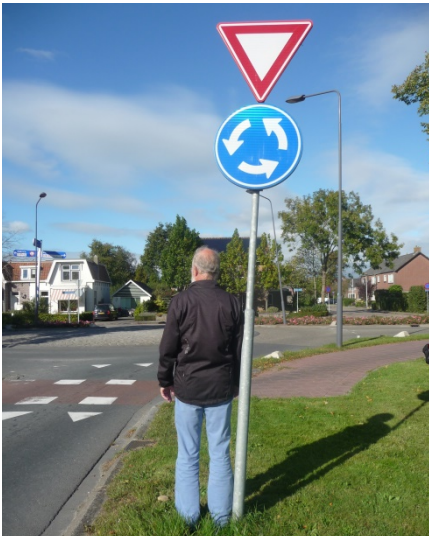
Rotondebord staat veel te hoog, alle belijning is vervaagd bij de rotonde.
