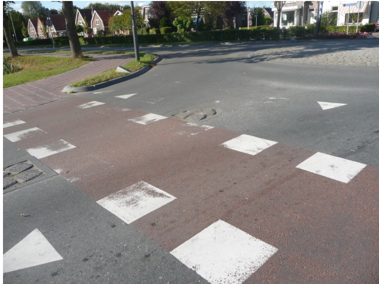
Rotondebord staat veel te hoog, alle belijning is vervaagd bij de rotonde.
