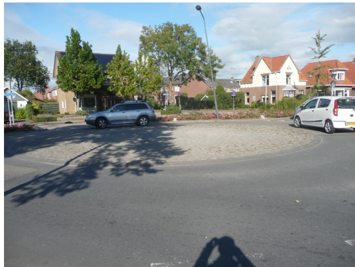
Rotonde is niet te zien, daarom rijden automobilisten er soms dwars overheen. Het voorstel vanuit Plaatselijk Belang is : er een fluorriserende verf om de rand van de rotonde aan te brengen, zodat die opvalt. De stenen in het midden van de weg heeft geen zin, niemand ziet ze.
